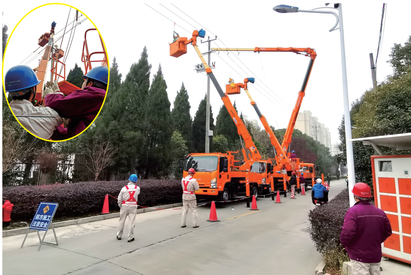
工作人员有条不紊地开展不停电加设断路器作业。
