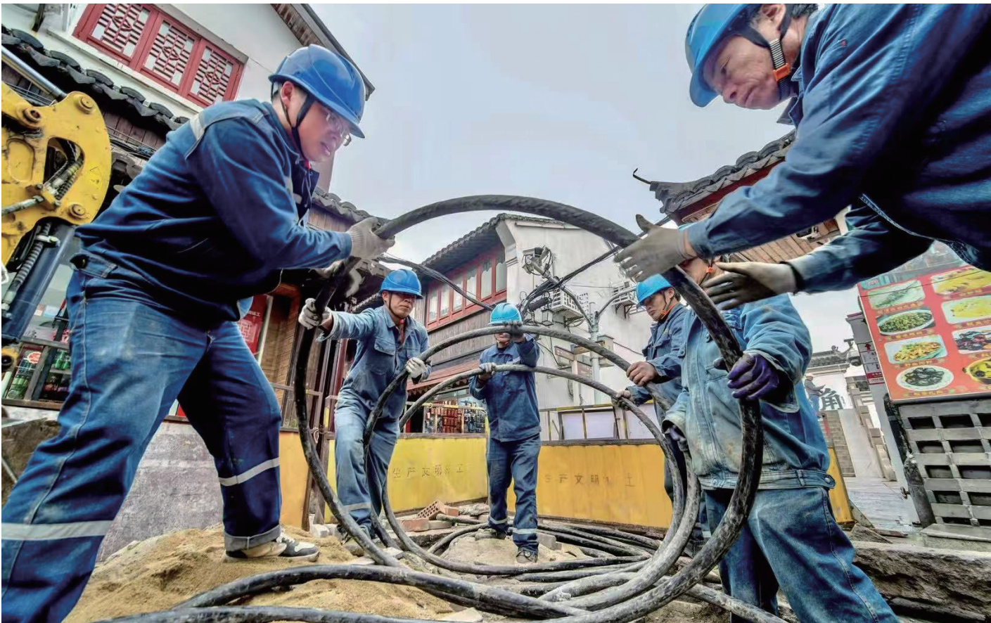
抢修队员在现场排除故障。
