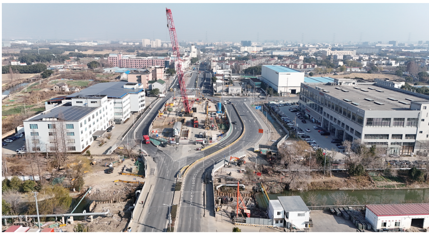
北青公路改扩建项目正有条不紊建设中。
